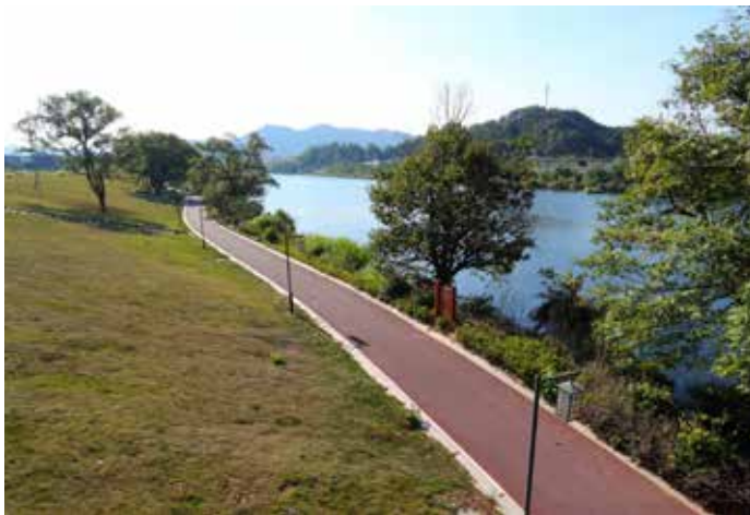
▲ 马金溪治理后
