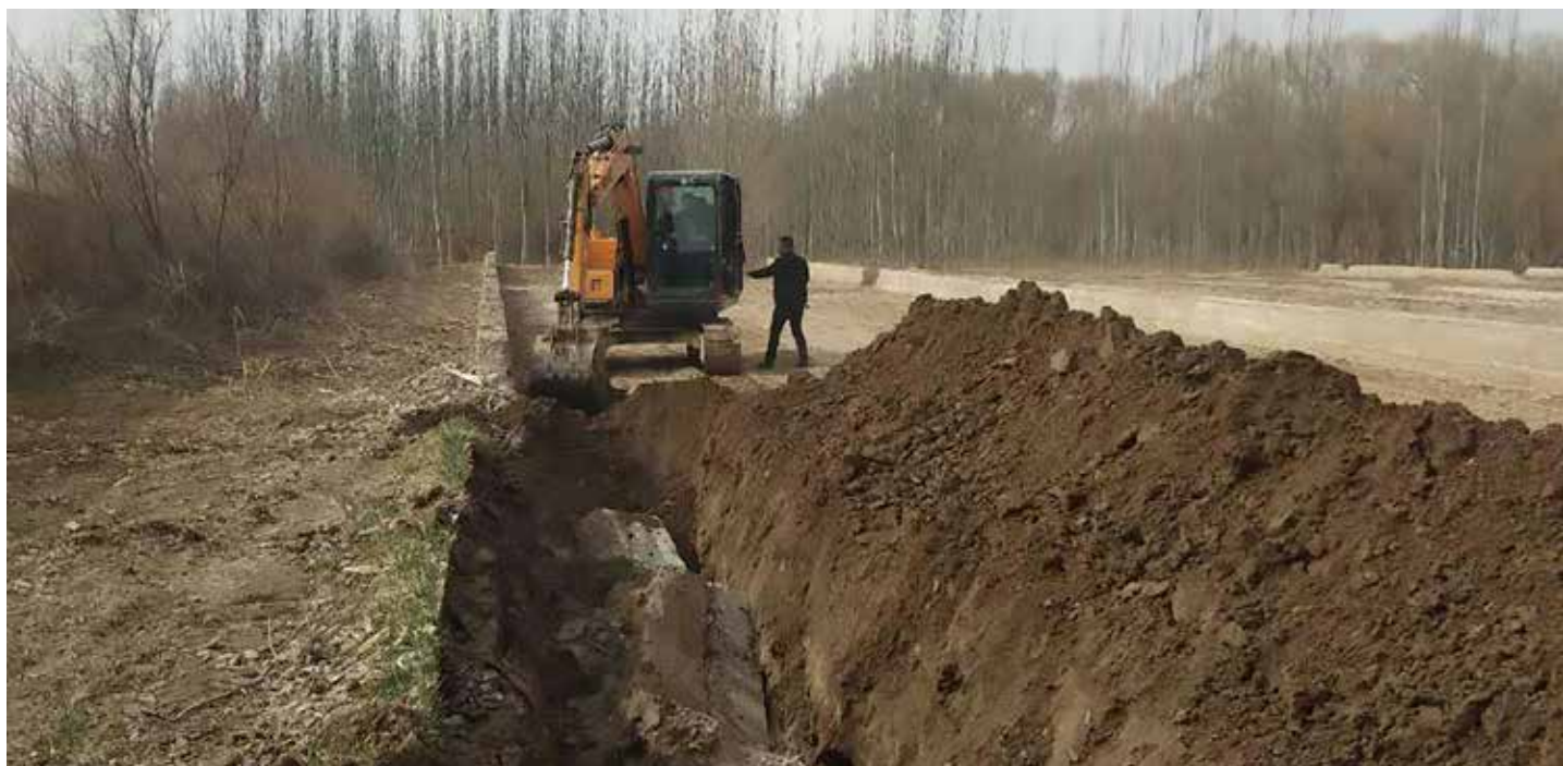
▲ 下二沟王志强养殖场拆后
