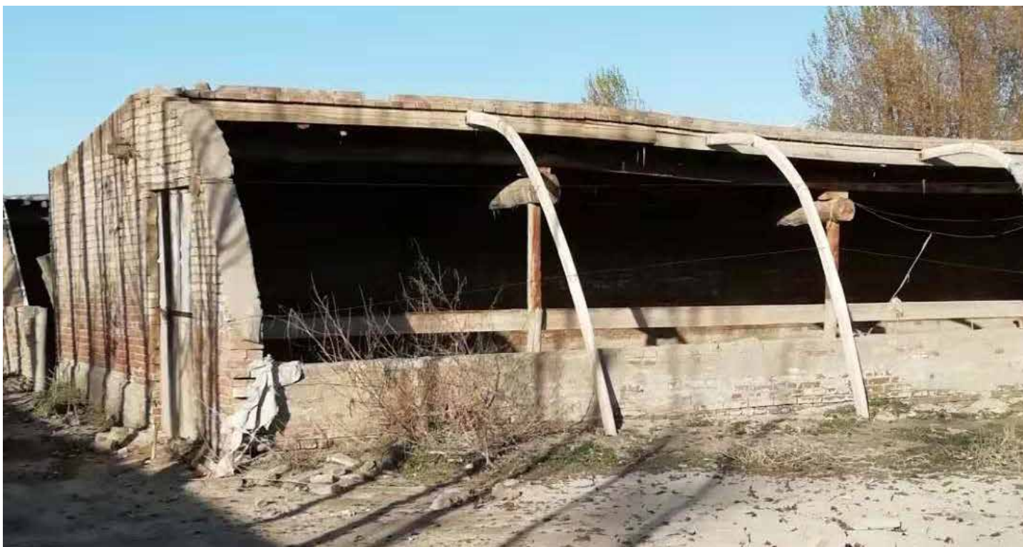
▲ 下二沟王志强养殖场拆前
