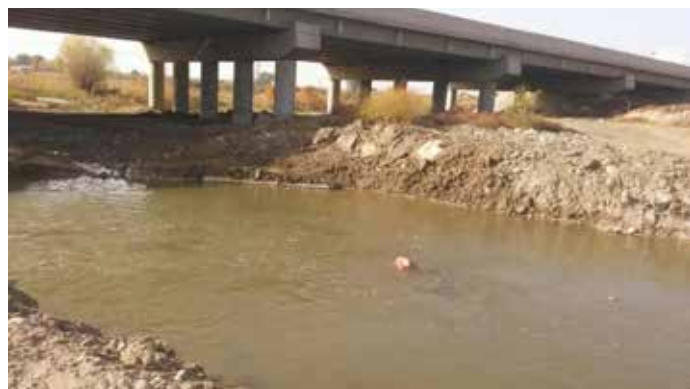
▲ 松涛大桥拆除后
