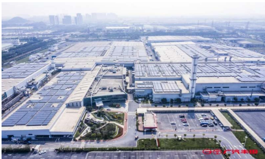
园区企业厂房建设分布式光伏发电项目
