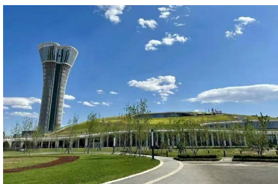
雄安新区垃圾综合处理设施
