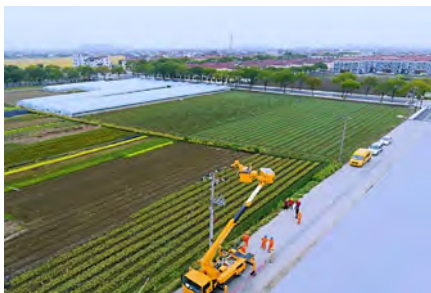
铺设高压电缆
