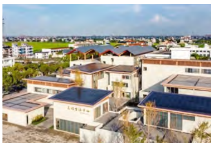
村民居试点屋顶光伏
