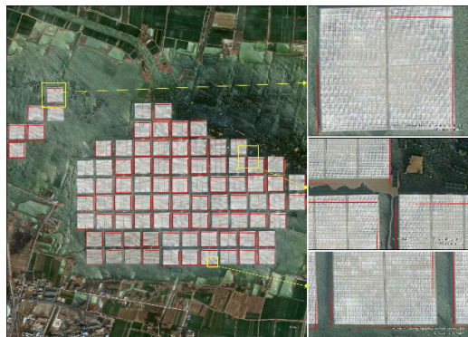
(7) 安徽颍上县光伏电站
