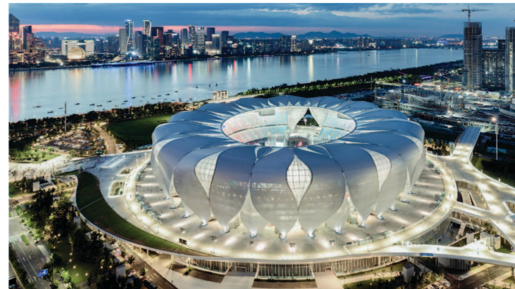
图 2-3 杭州奥体中心“大莲花”体育场
