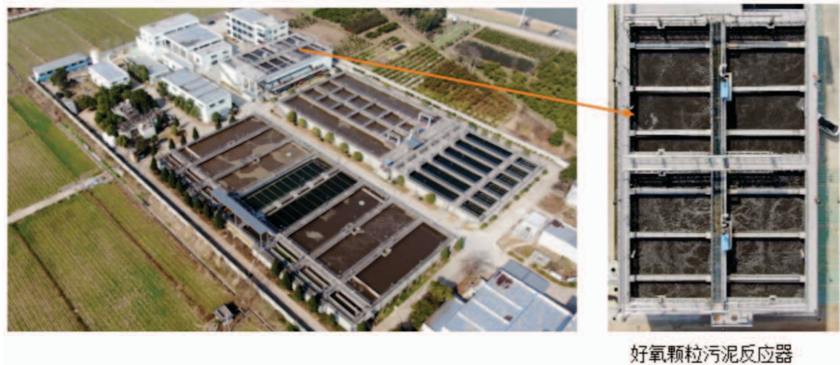
图 3-4 污水处理装置现场及污泥颗粒培养图
