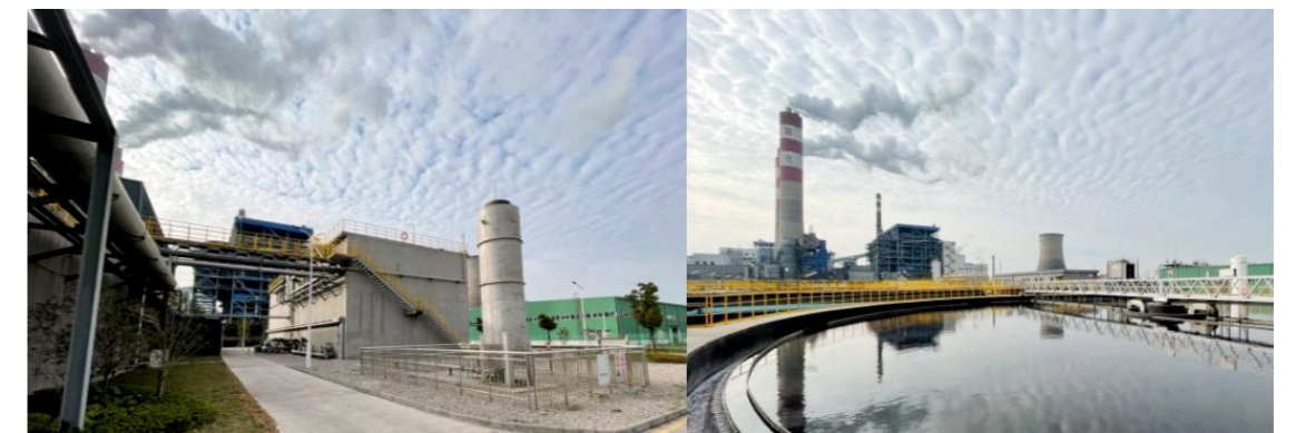
图 3-6 硫代碳反硝化污水处理装置现场图
