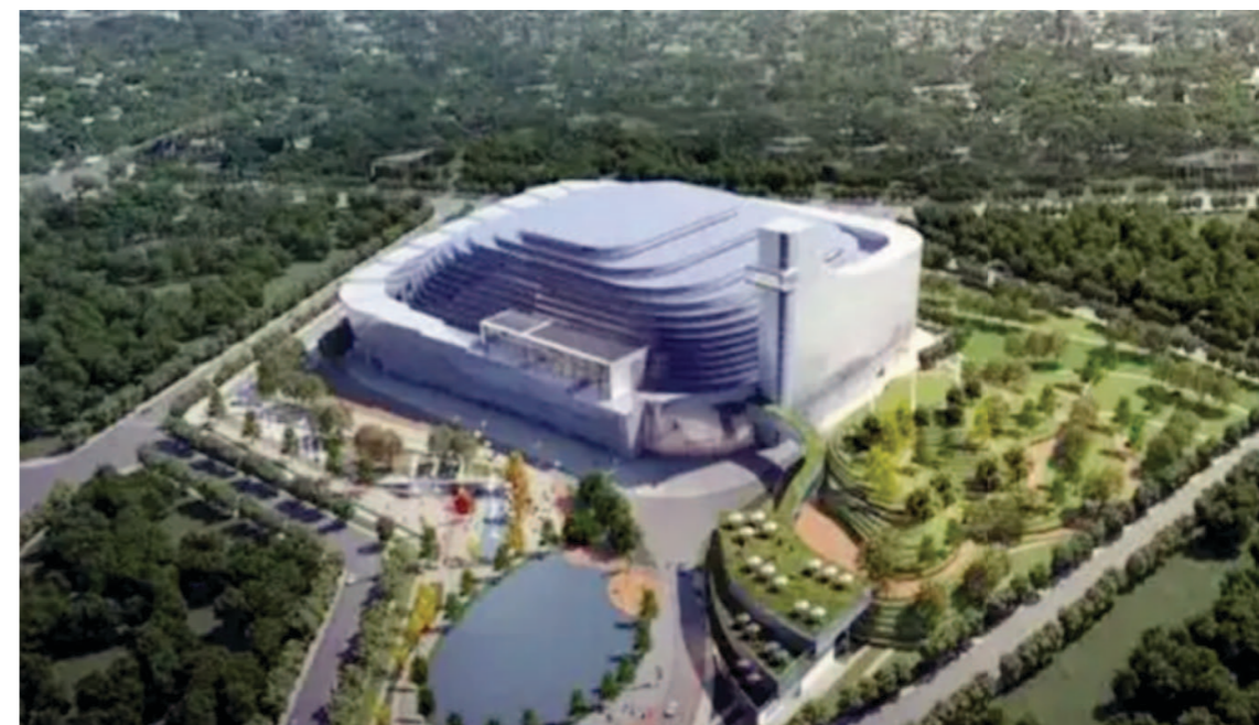
图 3-9 赤岸镇绿色低碳循环产业园垃圾焚烧发电厂
